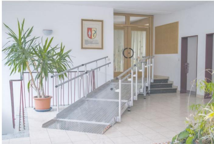
Das stationäre Rampensystem vom Typ RLS der Altec GmbH ermöglicht barrierefreie Rampenzugangssysteme zu Gebäuden und in Gebäuden.
